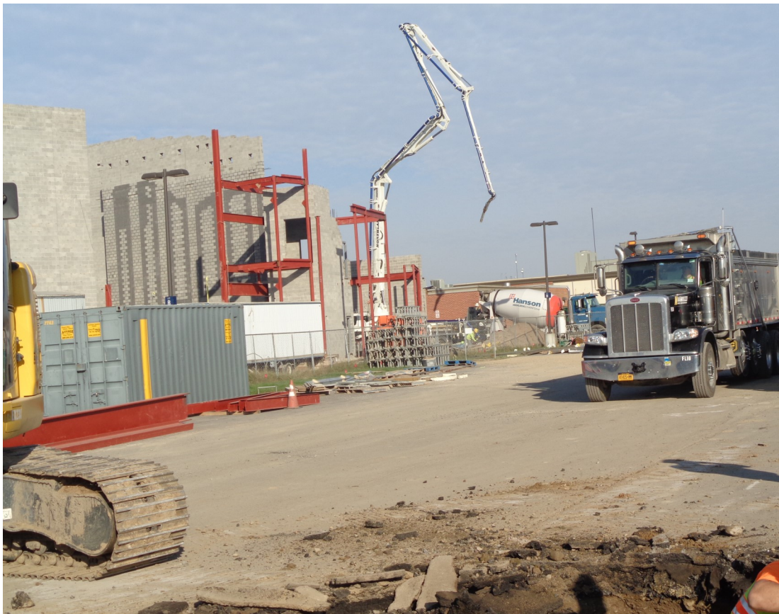
Concrete Pump for Air Handler Mezzanine Pour
